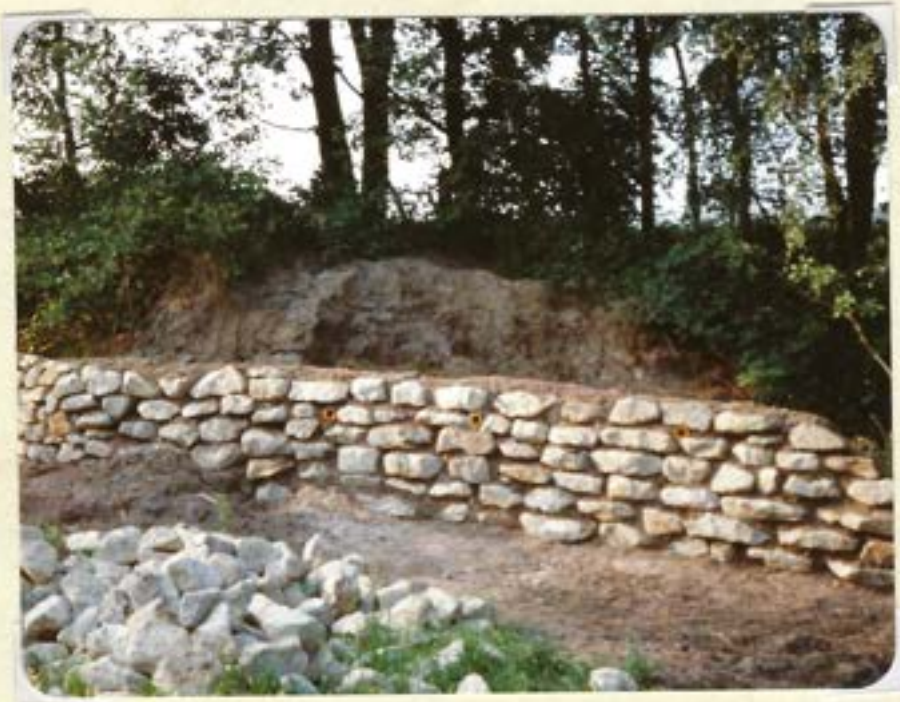
Naturmauer in Vorbereitung
